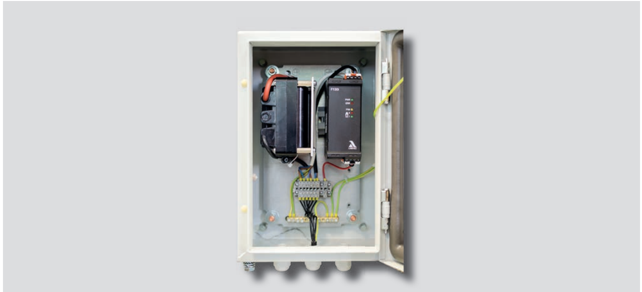
Externe Leistungseinheit sicherer Bereich
