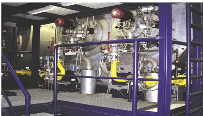
**Referenzanlage Bayerische Julius-Maximilians-Universität Würzburg: Doppelflammrohr Heißwasserkessel mit 14 MW, ausgerüstet mit zwei Ray-Brennern und CO-Regelung**
