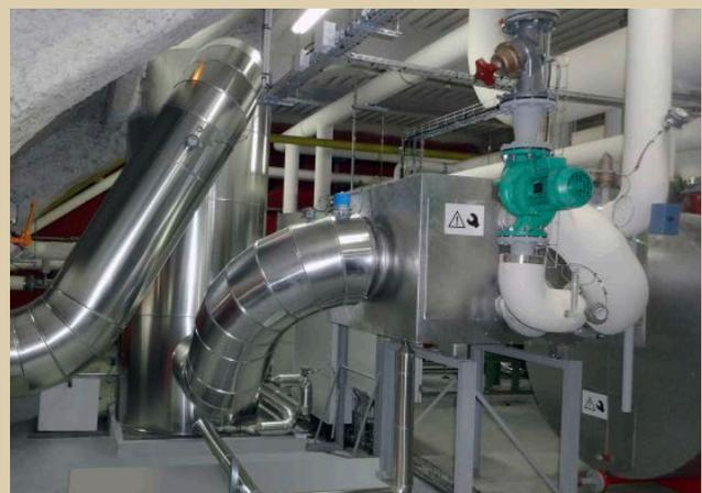
première tour. Grâce à cette mesure, les gaz de combustion sont refroidis de 80 °C à 40 °C. L'eau chauffée qui s'égoutte se rassemble au fond de la deuxième tour d'où elle est à nouveau pompée vers la première tour d'air, où elle enrichit et chauffe l'air d'admission. Le circuit de l'eau est ainsi fermé.
