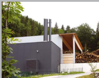
Dargestellt: Heizwerk in Fuschl am See
