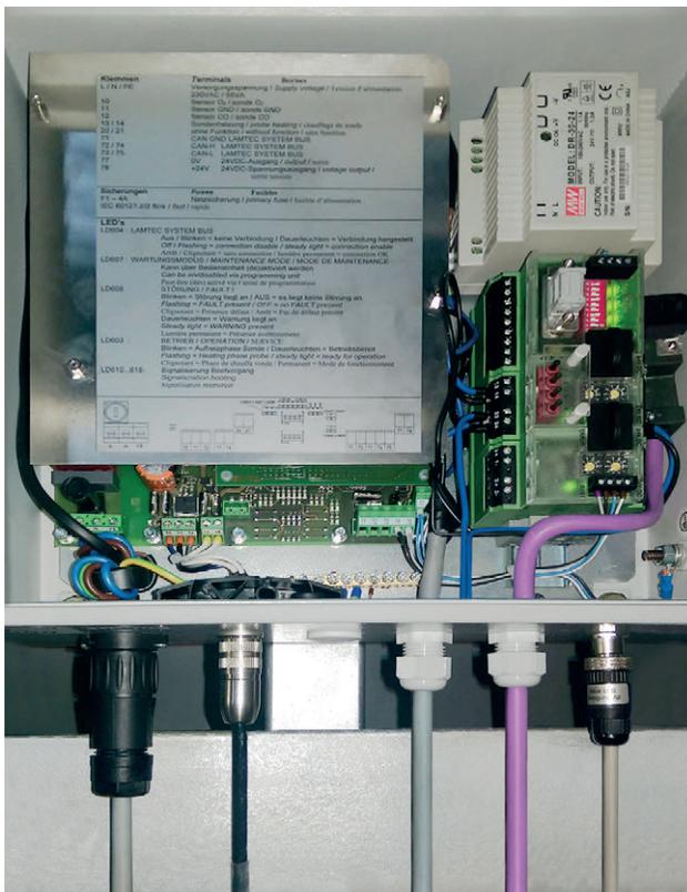
Die simultane Messung und Detektion von CO<sub>e</sub> (CO/H<sub>2</sub>) und O<sub>2</sub> mit dem LAMTEC Lambda Transmitter LT3 stellt eine signifikante Verbesserung gegenüber der alleinigen O<sub>2</sub>-Messung dar. Sie ermöglicht eine präzisere und schnellere Überwachung der Sensitivität und liefert erstklassige Basiswerte für eine nachgeschaltete Regelung von Luft- und Brennstoffzufuhr.
