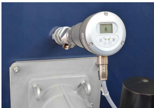
Der LAMTEC Flammenwächter F300K in Betrieb.
