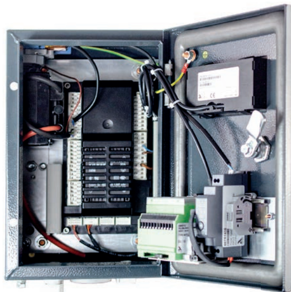
LAMTEC Burnercontrol BC300 als Einbau im Wandgehäuse
