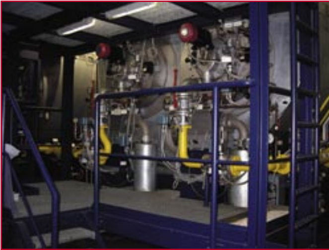
Referenzanlage Bayerische Julius-Maximilians-Universität Würzburg: Doppelflammrohr Heißwasserkessel mit 14 MW, ausgerüstet mit zwei Ray-Brennern und CO-Regelung
