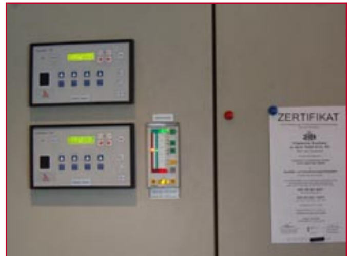
2 x ETAMATIC S elektronische Brennstoff-/Luftverbundregelung mit integrierter Drehzahlregelung des Verbrennungsluftgebläses und CO/O 2 -Regelung
