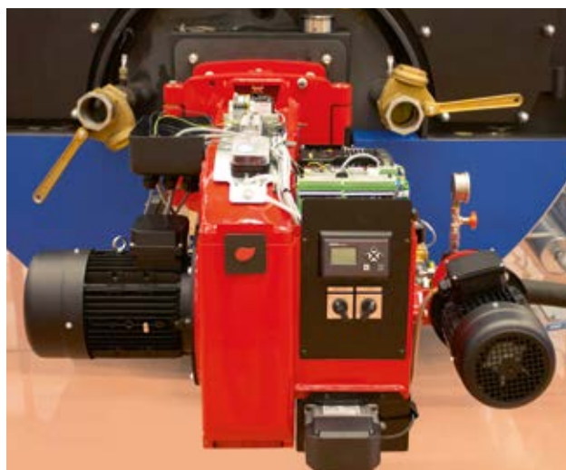
BT320 montée sur le brûleur.
